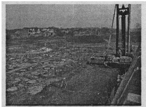
图 1 桩基现场施工照片
