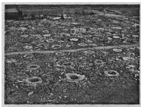
图 2 群桩施工照片
